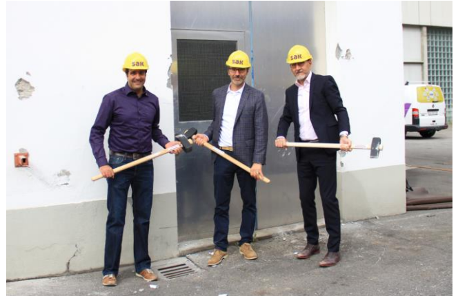
Hammerschlag als symbolischer Spatenstich (v.l.n.r.): Christian Neff (Projektentwickler Produktion, SAK), Adriano Tramèr (Geschäftsführer EW Schils AG und Leiter Produktion SAK) und Christoph Gull (Gemeindepräsident Flums).
