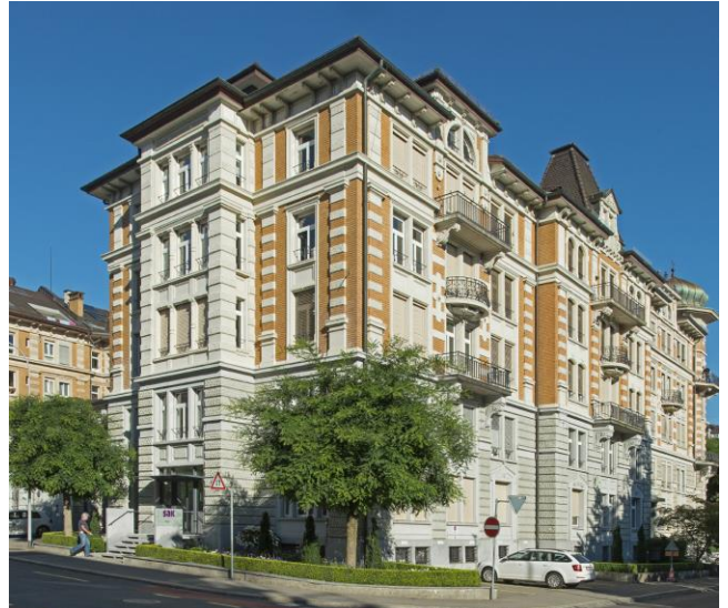
Ab dem 27. Mai 2019 wird der SAK Hauptsitz mit Fernwärme der städtischen Kehrrechtverbrennungsanlage beheizt.
