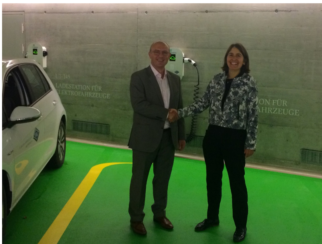
Freuen sich über die neu installierten Ladestationen: Romeo Caputo, Leiter Parkhäuser der Amag Services AG und Alexandra Asfour, Leiterin E-Mobilität der SAK.
